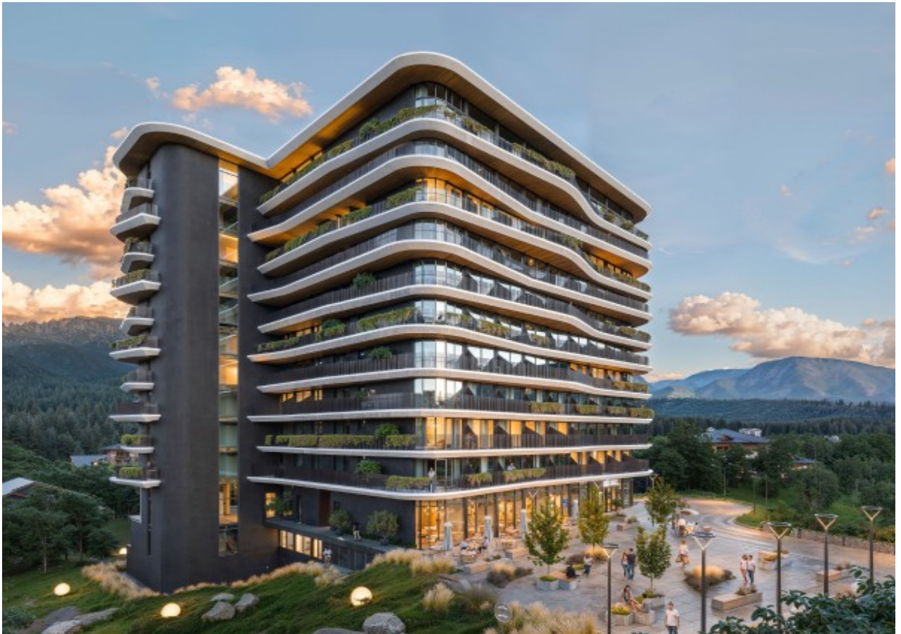
Рис.2.1.1. Загальний вигляд комплексу
