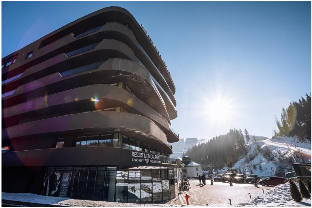
Рис.2.1.2 Загальний вигляд комплексу
