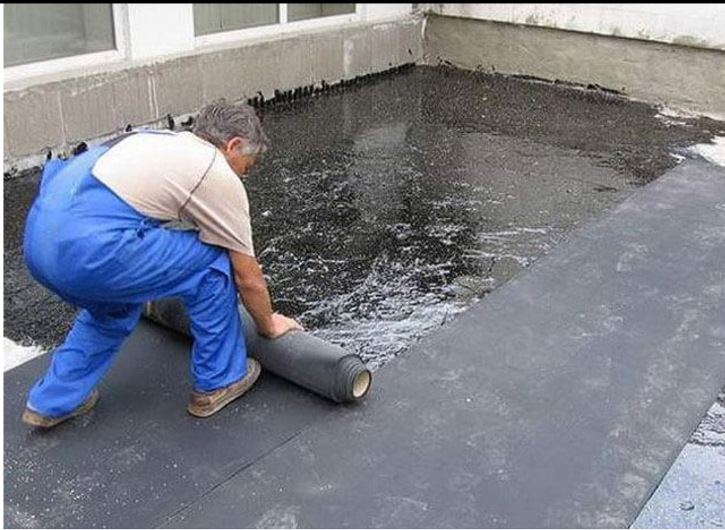
Рис. 7.1 Укладання рубероїду
