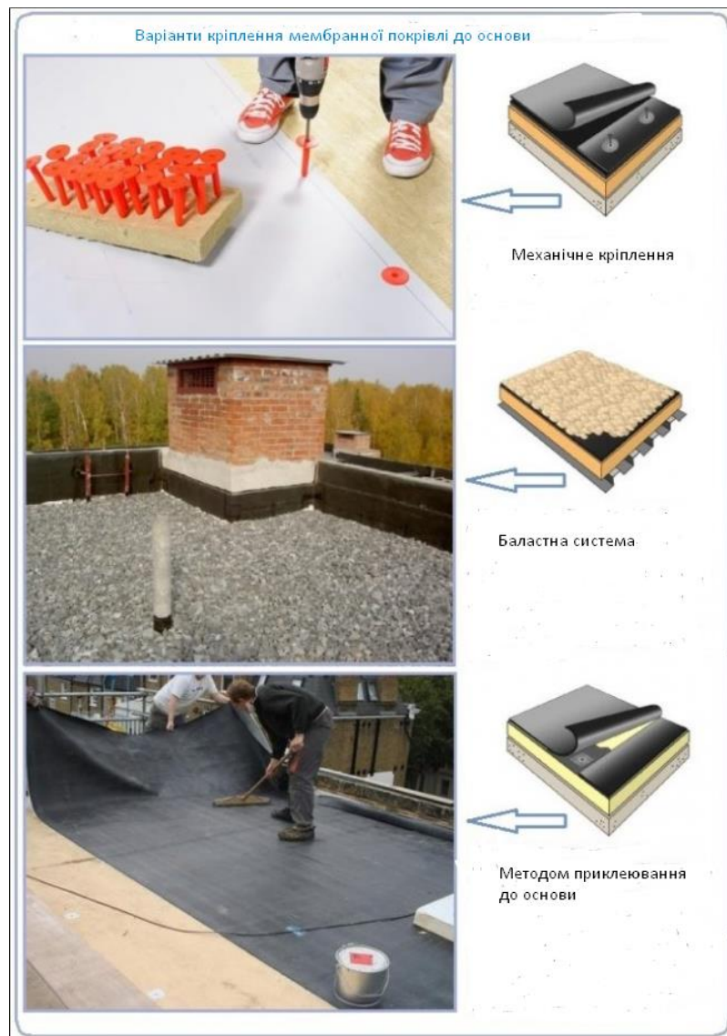
Рис. 7.2 Варіанти монтажу мембрани
