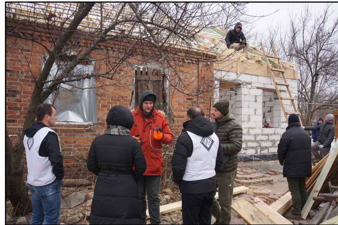
Відбудова пошкодженої будівлі
