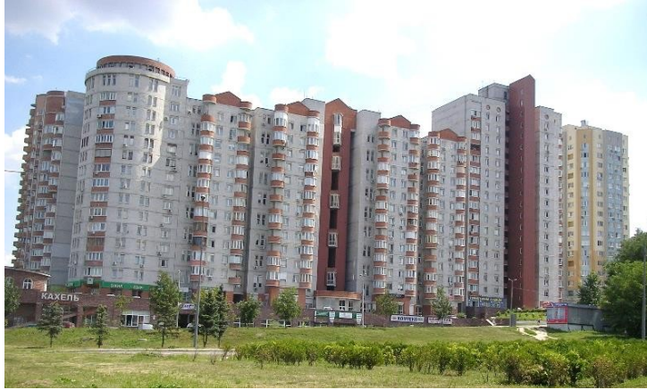
Рис. 2.8. Житловий комплекс (зовнішній вигляд). Фото автора
