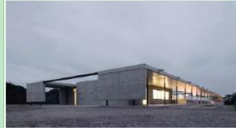
Центр відновлення морських тварин (Cram) Архітектор / Бюро: Hidalgo Hartmann Arquitectu Рік: 2010 Локація: El Prat de Llobregat (Барселона, Іспанія)
