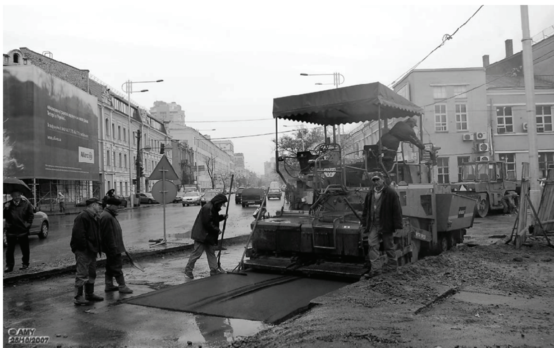
Рис. 1 Укладка асфальта в дождь
