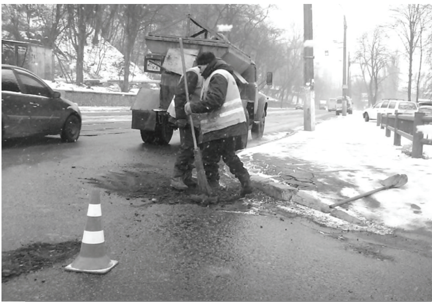
Рис. 2 Ямочный ремонт при низких температурах
