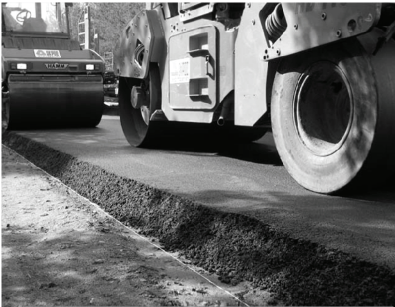
Рис. 3 Укладка первого слоя асфальта в Европе
