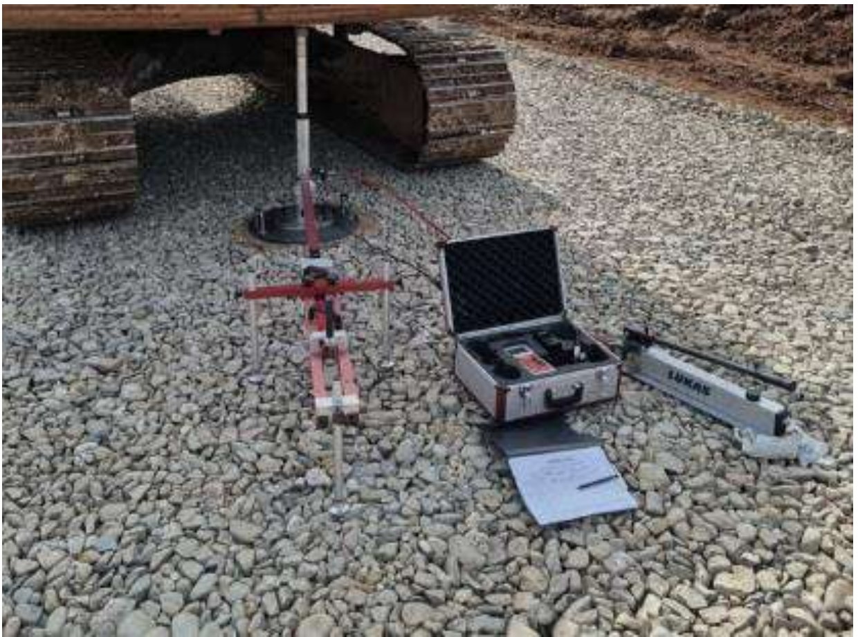
Проведення штампових випробовувань ґрунту установкою статичного навантаження "HMP PDG"
