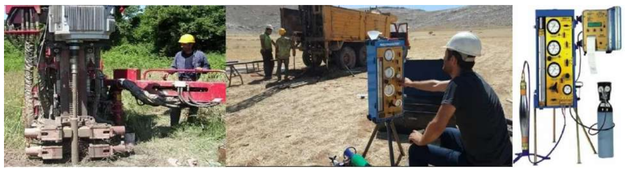
Проведення випробувань ґрунту пресіометром на будівельному майданчику
