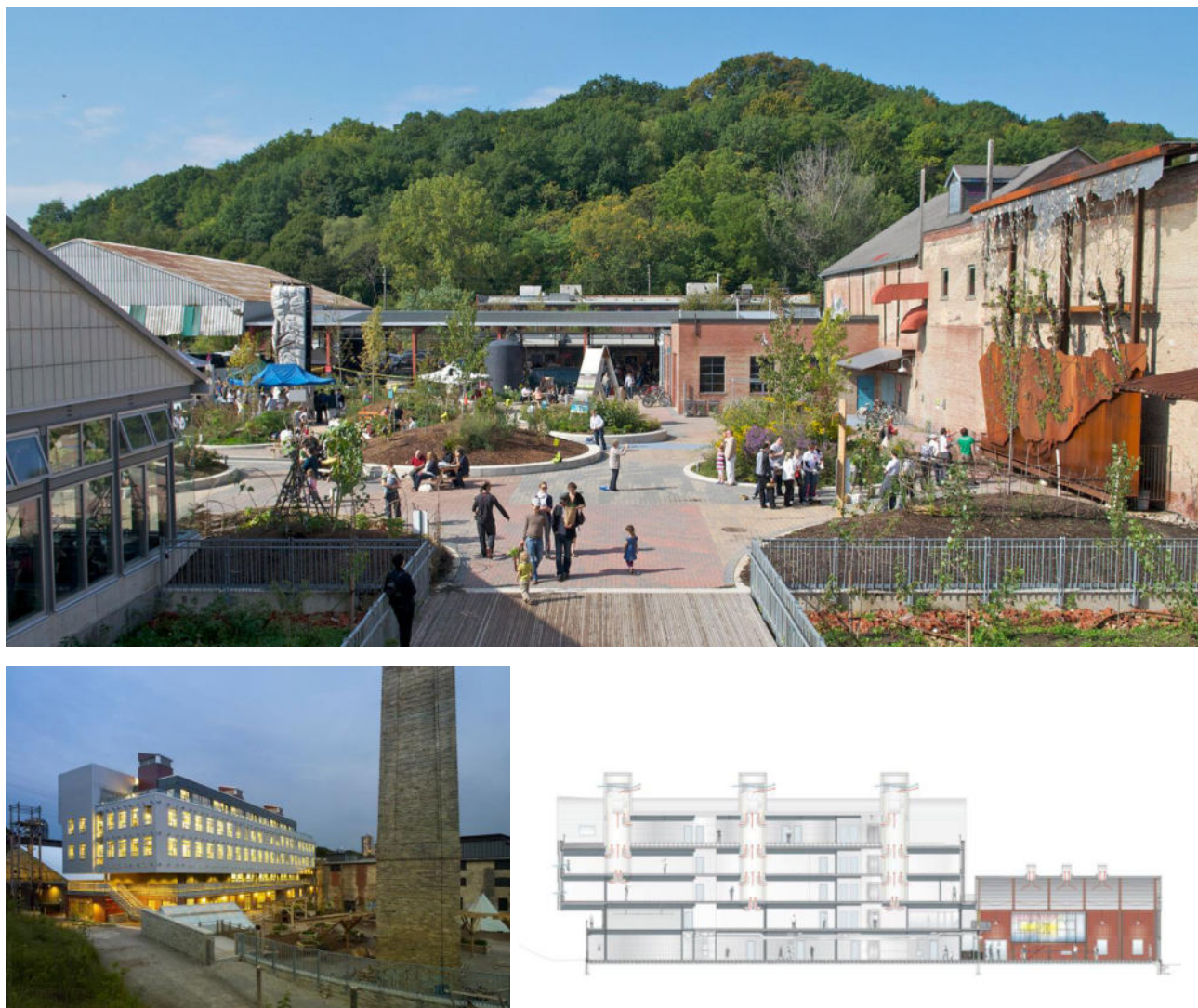
Рис. 1.3 Evergreen Brick Works, загальний вигляд ревіталізованого громадського простору, фото екстер'єру та розріз будівлі, Торонто, Канада, 2010, архітектори: Diamond Schmitt Architects, du Toit Allsopp Hillier [32, 33].
