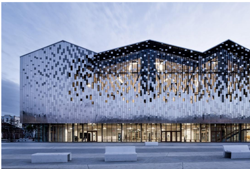
Рис. 2.6. Загальний вигляд будівлі « Pôle Simone Veil» [21]
