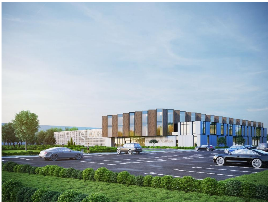
Рис. 2.9. Загальний вигляд будівлі «Багатофункціональний спортивний комплекс» [23]
