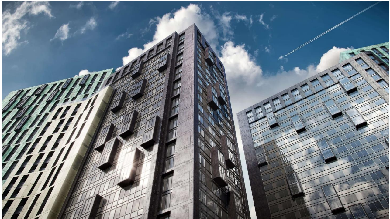
Рис. 2.5. Фасад будинку, де розташоване проектоване житло [20]
