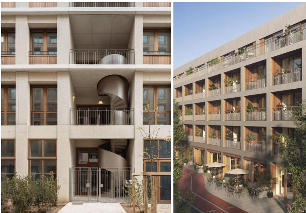
Рис 3.3.4. Приклад зовнішнього вигляду житлової архітектури [55]
