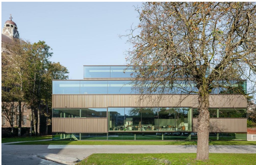
Рис.2.3.1 Загальний вигляд школи.
