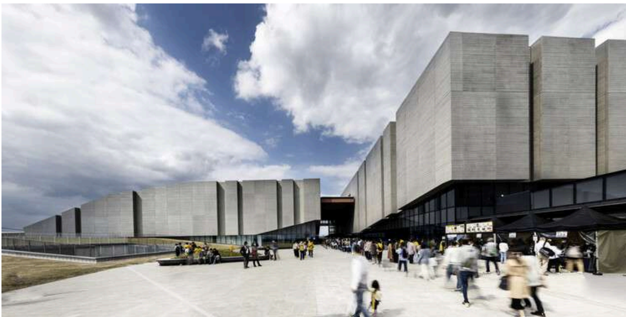
Рис. 2.30. Загальний вигляд комплексу [26]
