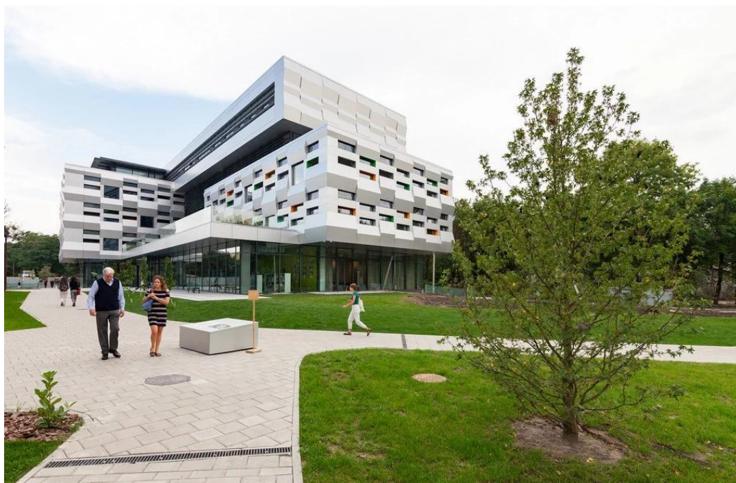
Рис. 2.36. Загальний вигляд на споруду; [40].
