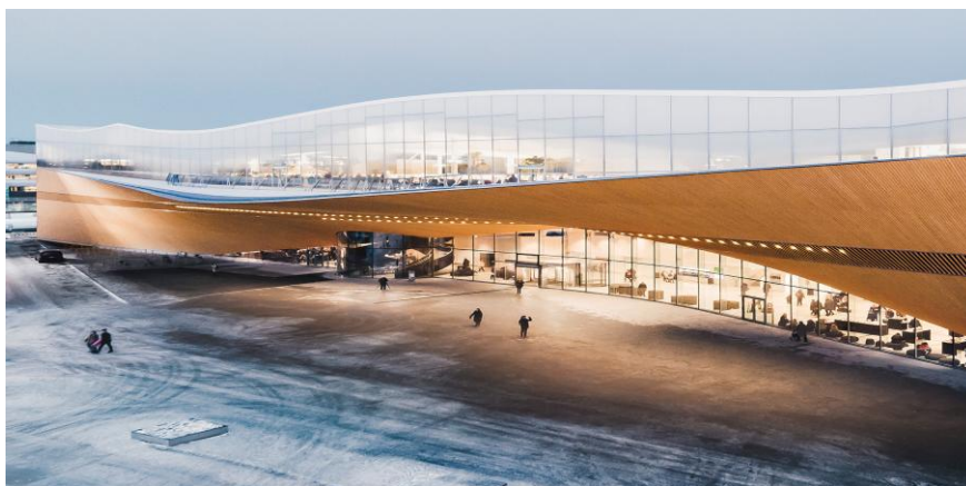
Рис. 2.1. Загальний вигляд бібліотеки «Ооді» [23].
