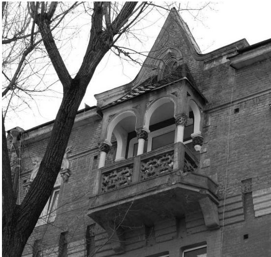
Рис. 8. Балкон з будинку у м.Києві по вул.Гоголівській, 23. Сучасний вигляд
