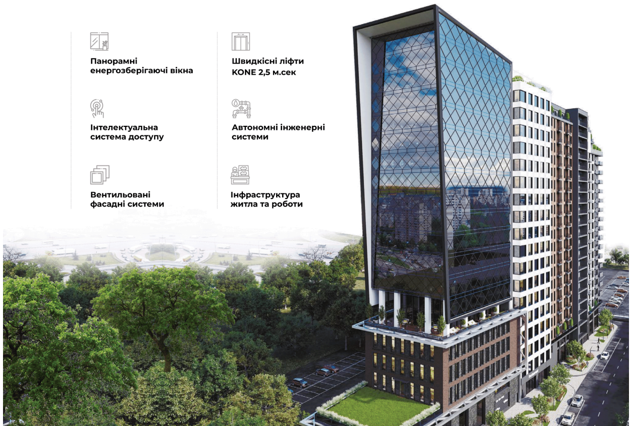
Рис. 2.3. Зовнішній вигляд будівлі під офіс [20]
