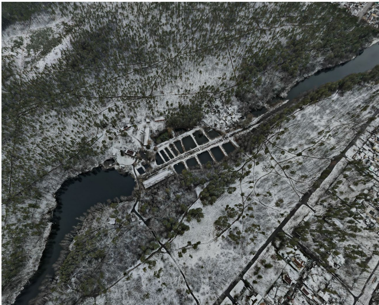
Теперішній вигляд ділянки
