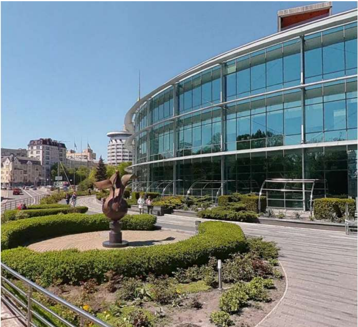
Рис. 2.3 – Фотофіксація будівлі з перспективою на вулицю
