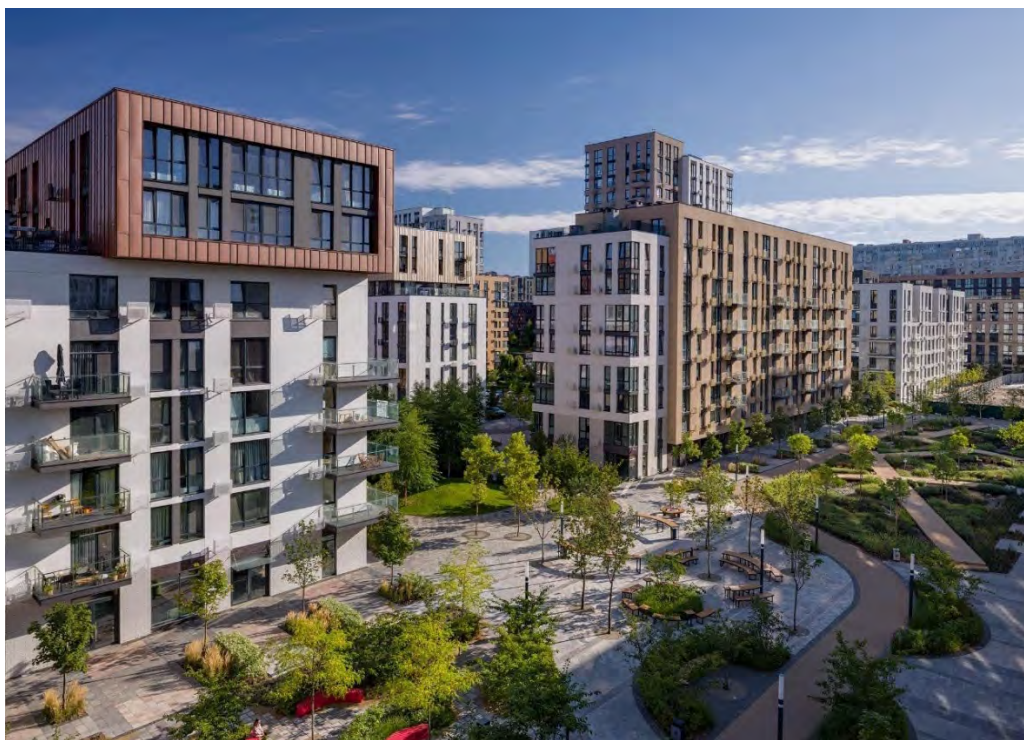
Рис. 2.14. Житловий комплекс «Файна Таун» у Києві (арх. ARCHIMATIKA): формування комфортного житлового середовища через квартальну забудову та розвинену мережу пішохідних маршрутів. [6]
