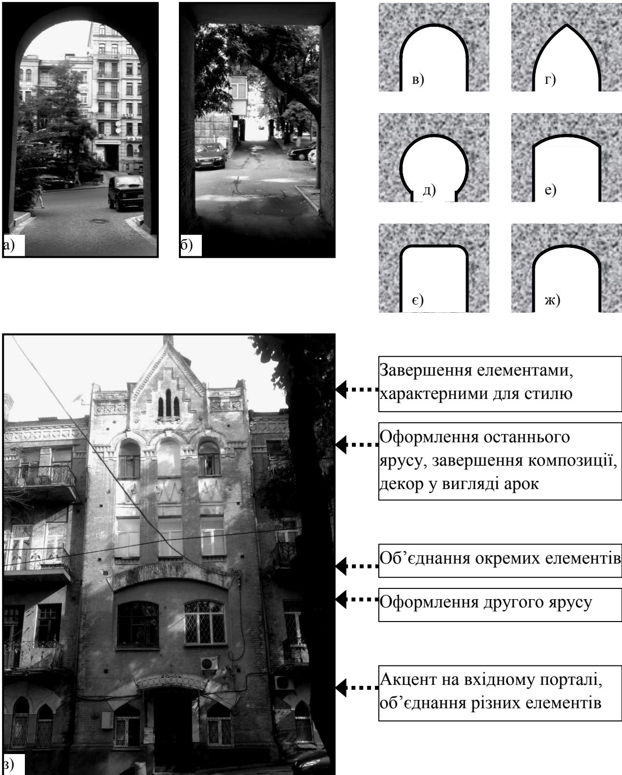
Рис. 3. Обмеження поля зору різними формами: а) аркою, б) прямокутником. Основні форми арок, які використовували у історичних прибуткових будинках Києва: в) циркульна, г) стрільчаста, д) підковоподібна, е) лучкова, є) стиснута, ж) еліптична. Фасад будинку по вул. О. Гончара: з) прийоми композиційного розташування арок.
