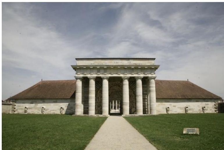
Рис. 2.1.27. Королівський соляний завод в Арк-е-Сенан, Вхідна будівля Королівської солеварні. Архіт. Клод-Нікола Леду [25; 35]
