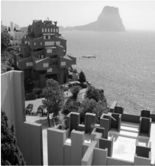
Житловий комплекс «Ксанаду». Архіт. Рікардо Бофілл [Bofill, Ricardo. Xanadú Housing Complex, Calpe, Spain [Електронне джерело] URL: https://ricardobofill.com/ projects/xanadu/ ]
