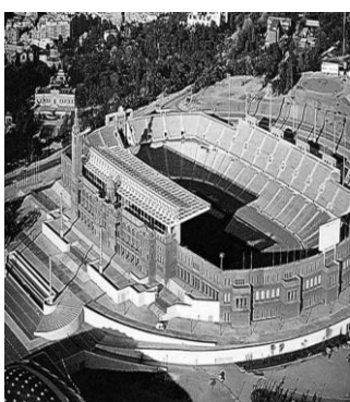
Олімпійський стадіон. Архіт. Вітторіо Греготті [American Institute of Architects. Six must-know Olympic landmarks for architecture lovers [Електронне джерело]. URL: https://www.aia.org/aia-architect/article/six-must-know-olympic-landmarks-architecture-lovers ]
