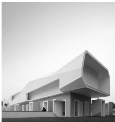
Будинок-автограф у Португалії. Архіт. Алваро Сіза [Álvaro Siza Vieira Official Website. [Електронне джерело]. URL: http://www.sizavieira.pt/ ]
