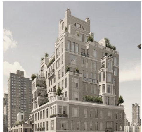
Рис. 1.2.4. 20 East End Avenue. Архіт. Р. Стерн [22]
