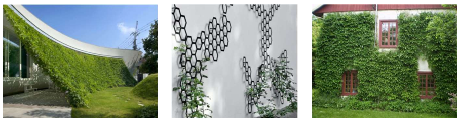
Рис. 4.3 – Приклади класичного вертикального озеленення: а) – зі застосуванням опори з сітки; б) – зі застосуванням опорного декоративного каркасу; в) – ліани, що чіпляються до стіни самі
