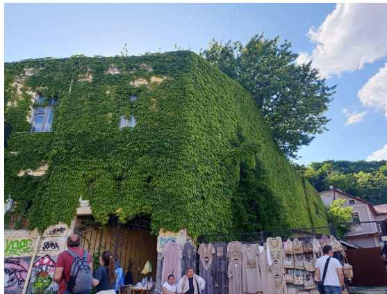
Рис. 4.34 – Приклад використання вертикального озеленення для маскуванню цивільних об'єктів: будівля на Подолі (фото автора Ткаченко Т.М, 2022 р.)
