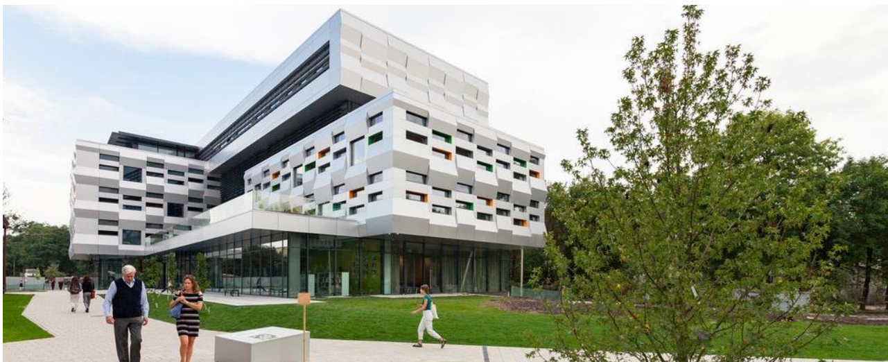
Рис.2.2.26. Фотографія будівлі Багатофункціонального Центру [52].
