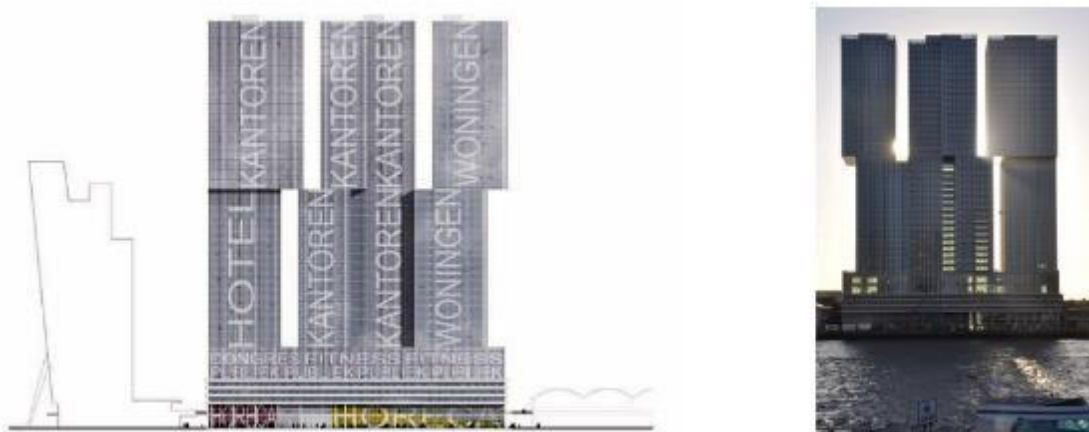
Рис.2.5 Багатофункціональний комплекс ДеРоттердам. Архітектори ОМА [63]
