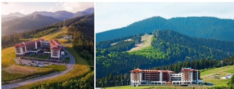
Рис. 2.1.3 Radisson Blu Resort Bukovel (с. Яблуниця) [5]– загальний вигляд
