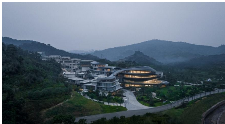
Рис. 2.2.3 THALLO Boutique Hotel Cluster / BUZZ (Чжанджоу, Китай) [2] – Загальний вигляд будівлі
