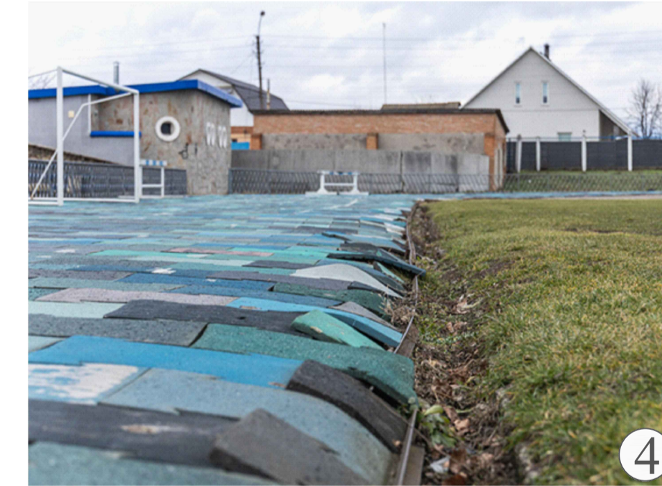
Технічний стан гумового покриття незадовільний, водозбірний лоток потребує заміни
