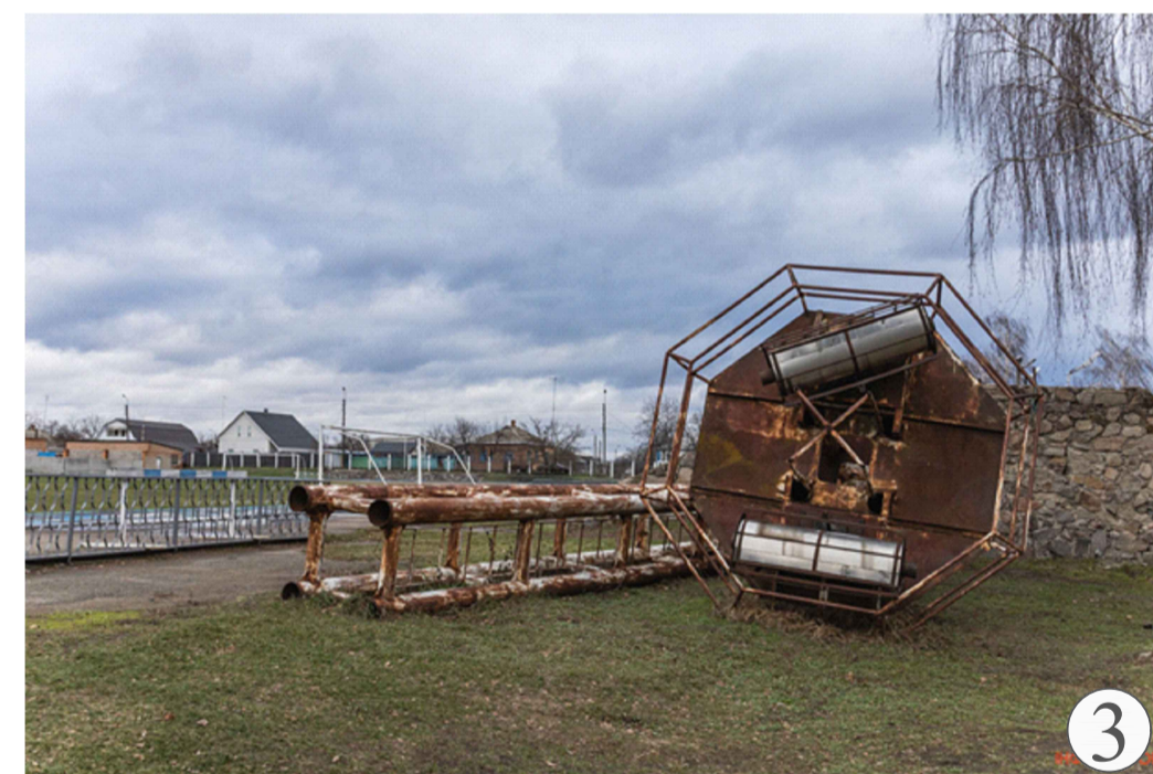
Демонтовані мачти освітлення продовжують ржавіти на території комплексу
