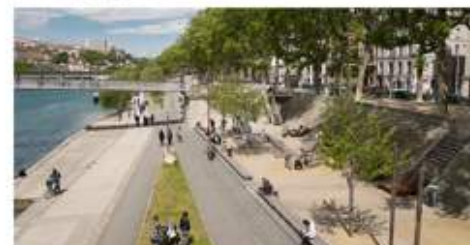
Реконструйована набережна річки Рона в межах історичного центру м.Ліон, Франція (Berges du Rhône)
