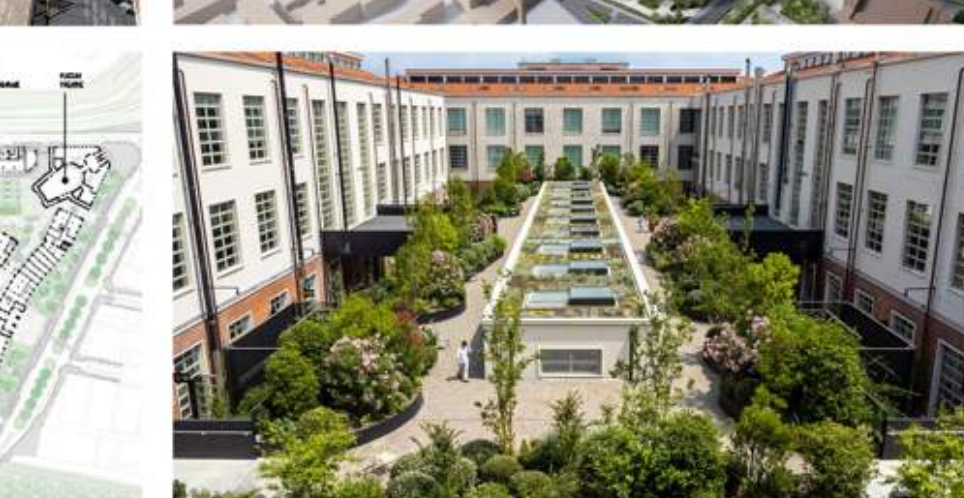
Комплекс колишньої тютюнової фабрики, інтегрований у міську структуру м.Флоренція, Італія (Manifattura Tabacchi)
