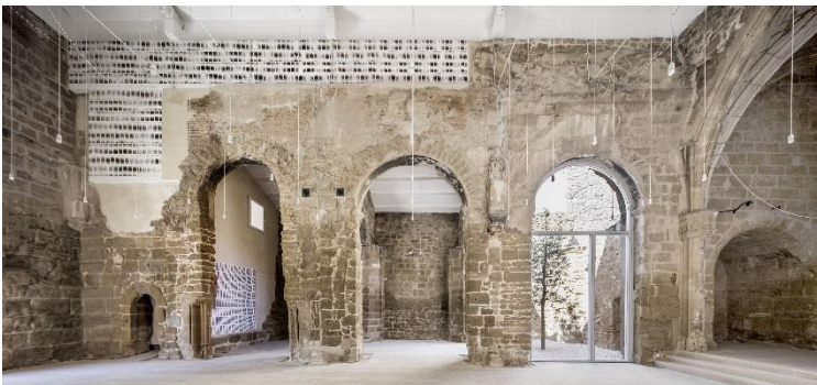
Рисунок 10. Відновлення втрачених фрагментів конструкції новими та актуалізованими методами. [12]
