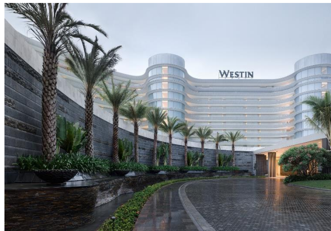
Рис. 2.12. Фрагмент внутрішнього двору внутрішнього двору[19]
