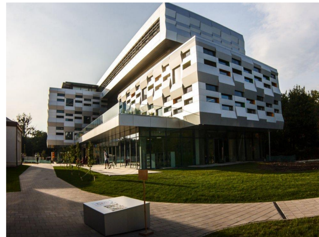
Рис.4.6. Центр митрополита Андрія Шептицького Українського католицького університету у Львові — приклад інклюзивного освітнього центру
