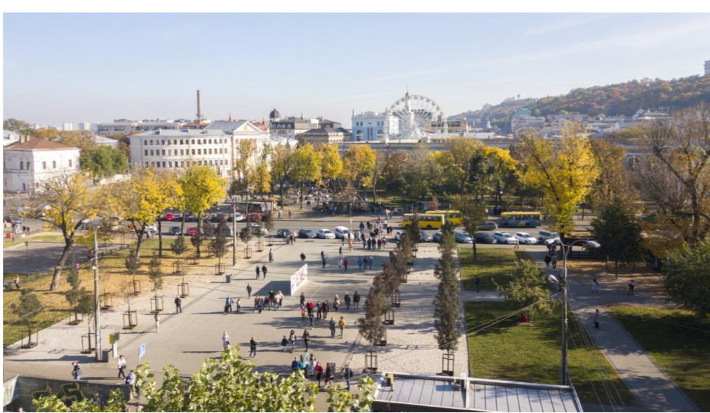
Рис.3.10. 1-й етап реконструкції Контрактової площі — відновлення скверу
