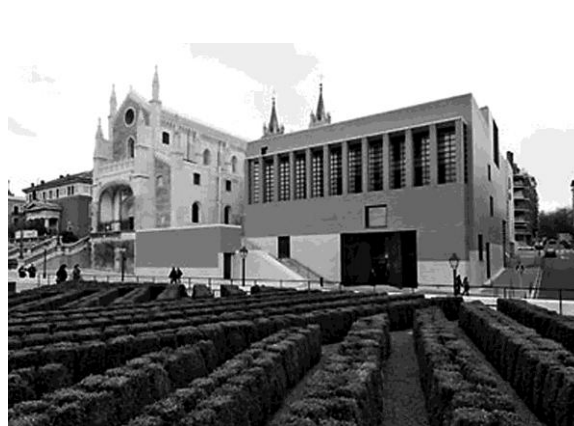
Рис.8. Музей Прадо, Мадрид, Испания, фасад нового здания.
