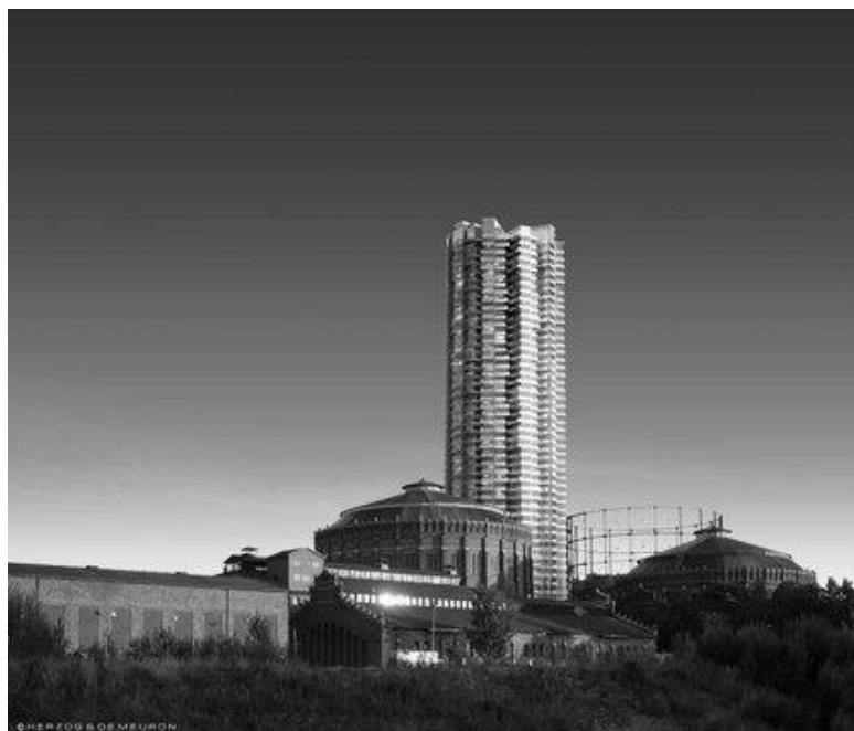
Рис. 2. Житловий комплекс, розміщений у колишньому газосховищі
