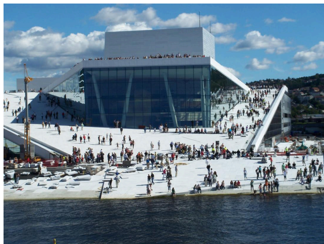
Рис. 2.2 Вид на експлуатовану покрівлю [22]
