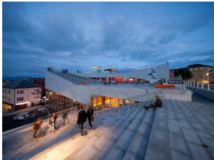
Рис. 2.24. Вид на експлуатовану покрівлю [29]
