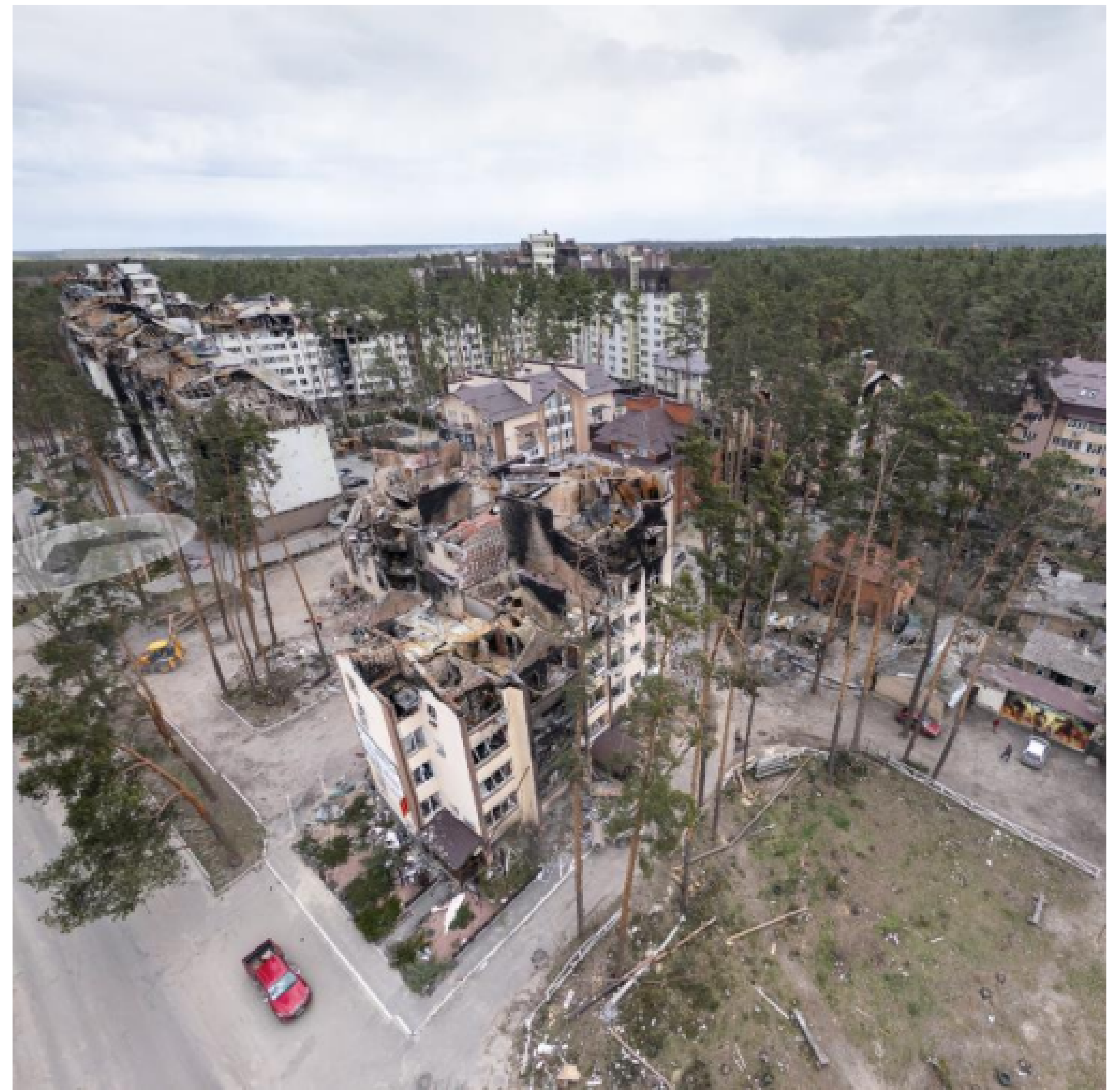
Забудова на ділянці станом на 2022р.
