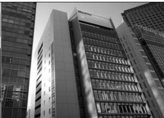
Рис. 2. Nikken Tokyo Building, Япония, 2003
