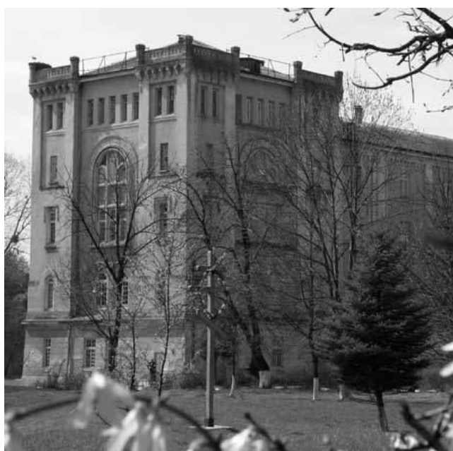
Фрагмент корпусу інституту в
