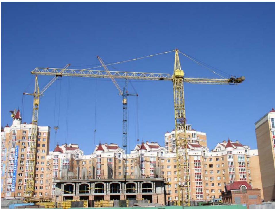
Рис. 1. Застосування баштових кранів УБК у будівництві м. Києва
