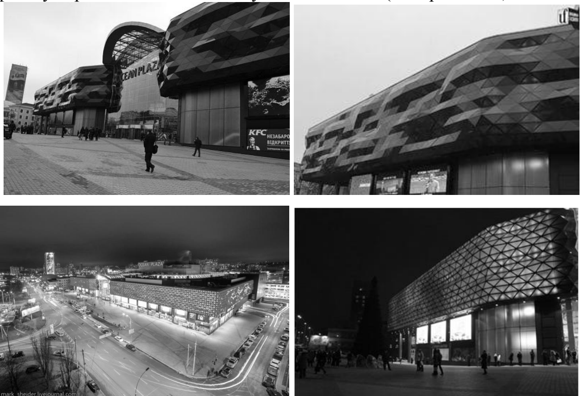
Рис. 1-4. Перспективні зображення ТРЦ «Ocean Plaza» у м. Києві за адресою: вул. Антоновича, 176 [ www.oceanplaza.com.ua ].
