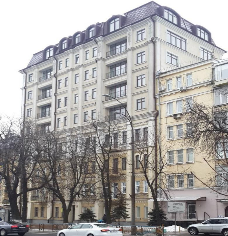
Фото 5. Головний фасад будинку після реконструкції.
