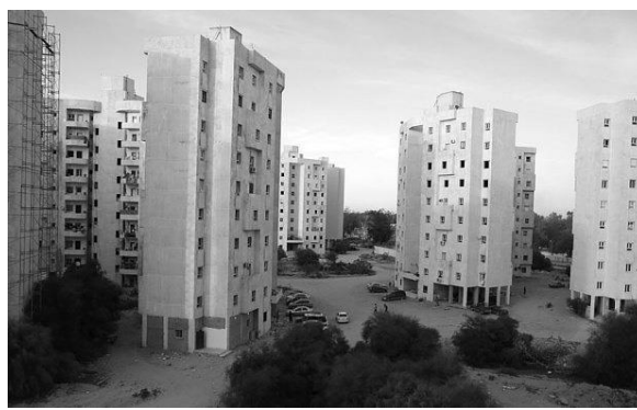
Рис.2. Незавершене будівництво житлового комплексу «Scrapyard Flats» у м.Тріполі, 2011р., фото Will Wintercross: https://www.telegraph.co.uk/news/worldnews/africaandindianocean/libya/11976639/
