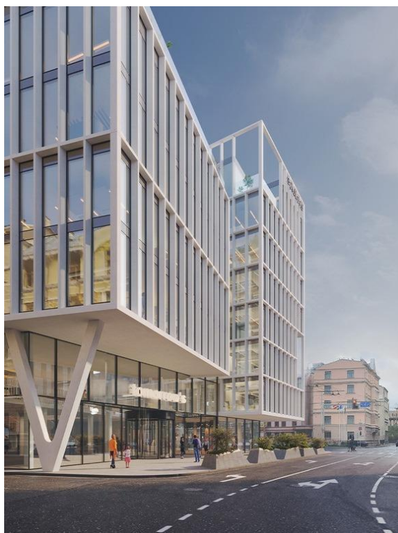
Рис. 2.1. Бізнес-центр Сатеклес, М. Рига, Латвія, Архітектурне бюро Lauder Architects и Sarma&Norde, 2025 [13] https://neighborhood.lv/ru/real-estate/satekles-business-center/
