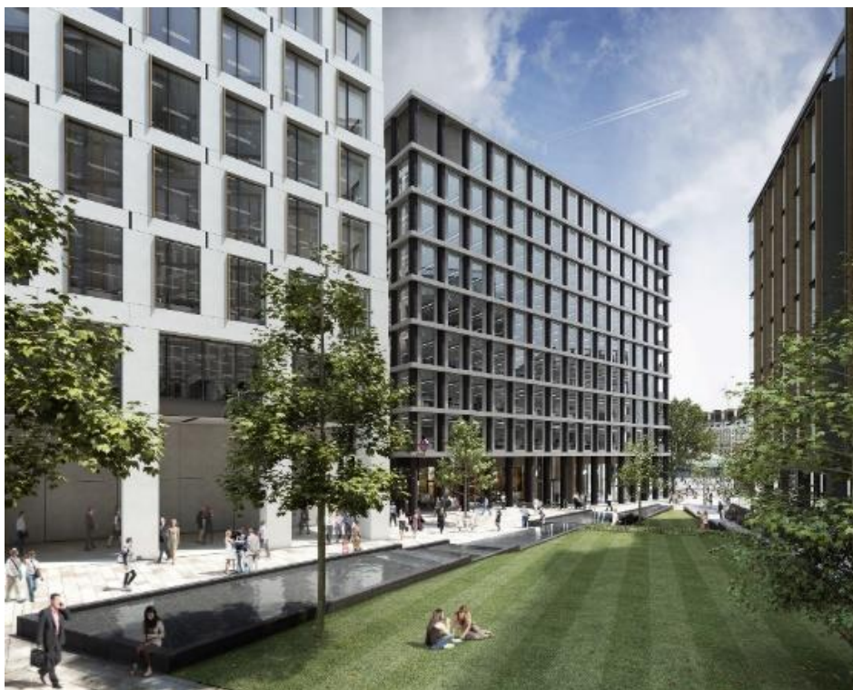
Рис. 2.5. Гридирон, площадь Уан-Сент-Панкрас, Внешний вид фасада здания / David Chipperfield Architects [16] https://www.archdaily.com/438007/gridiron-one-st-pancras-square-david-chipperfield/5255b9e4e8e44eff0200076d-gridiron-one-st-pancras-square-david-chipperfield-image
