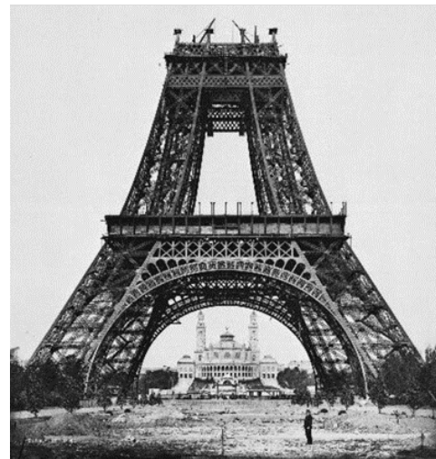
Рис.3. Ейфелева вежа 20 березня 1888 року після зведення першого рівня (а) [2] та 21 серпня 1888 року після зведення другого рівня (б) [2]
