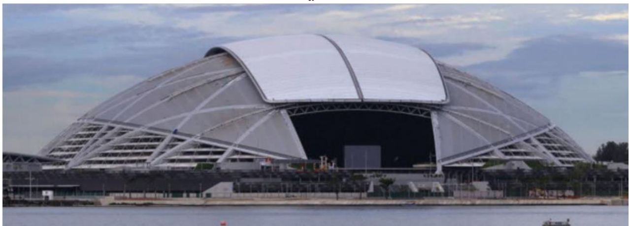
Рис.4. Національний стадіон Сінгапуру з відкритими (а) [10] та закритими (б) [5] розсувними частинами покриття куполу
