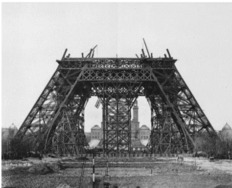
Рис.3. Ейфелева вежа 20 березня 1888 року після зведення першого рівня (а) [2] та 21 серпня 1888 року після зведення другого рівня (б) [2]
