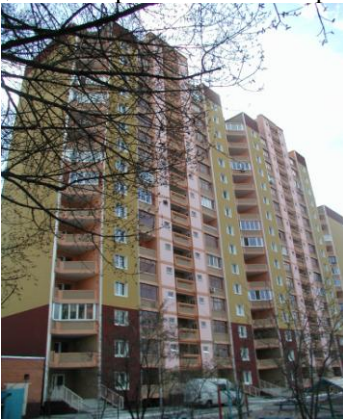
Рис. 1. Перший експериментальний житловий будинок серії АПВС К-134 з тепловентильованим фасадом по
