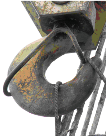
Рис. 1. Вихід стропа із гака крана КС- 6476
