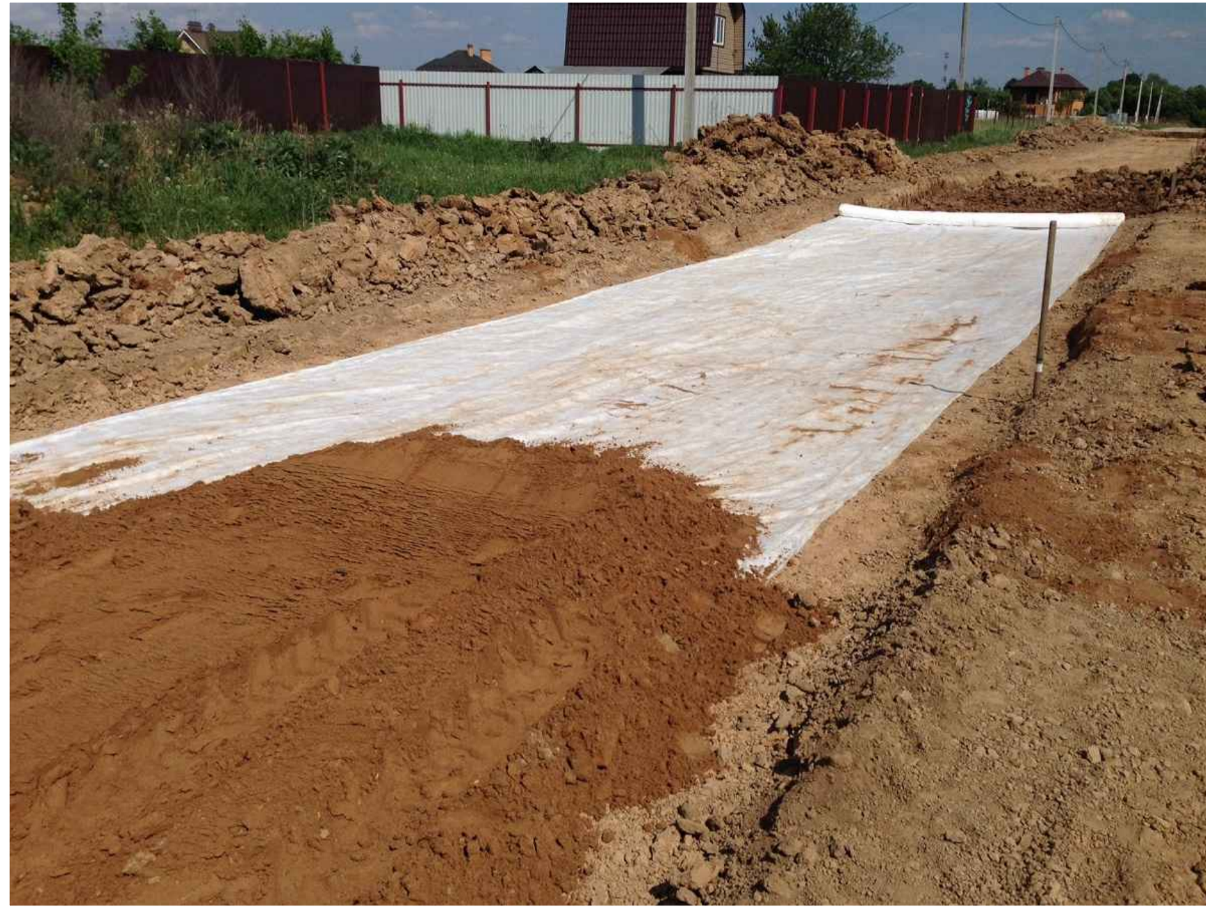
Приклад використання геокомпозиту
