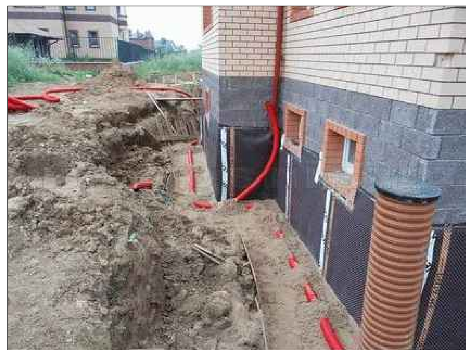
Рис.3 Приклад пристінного дренажу
