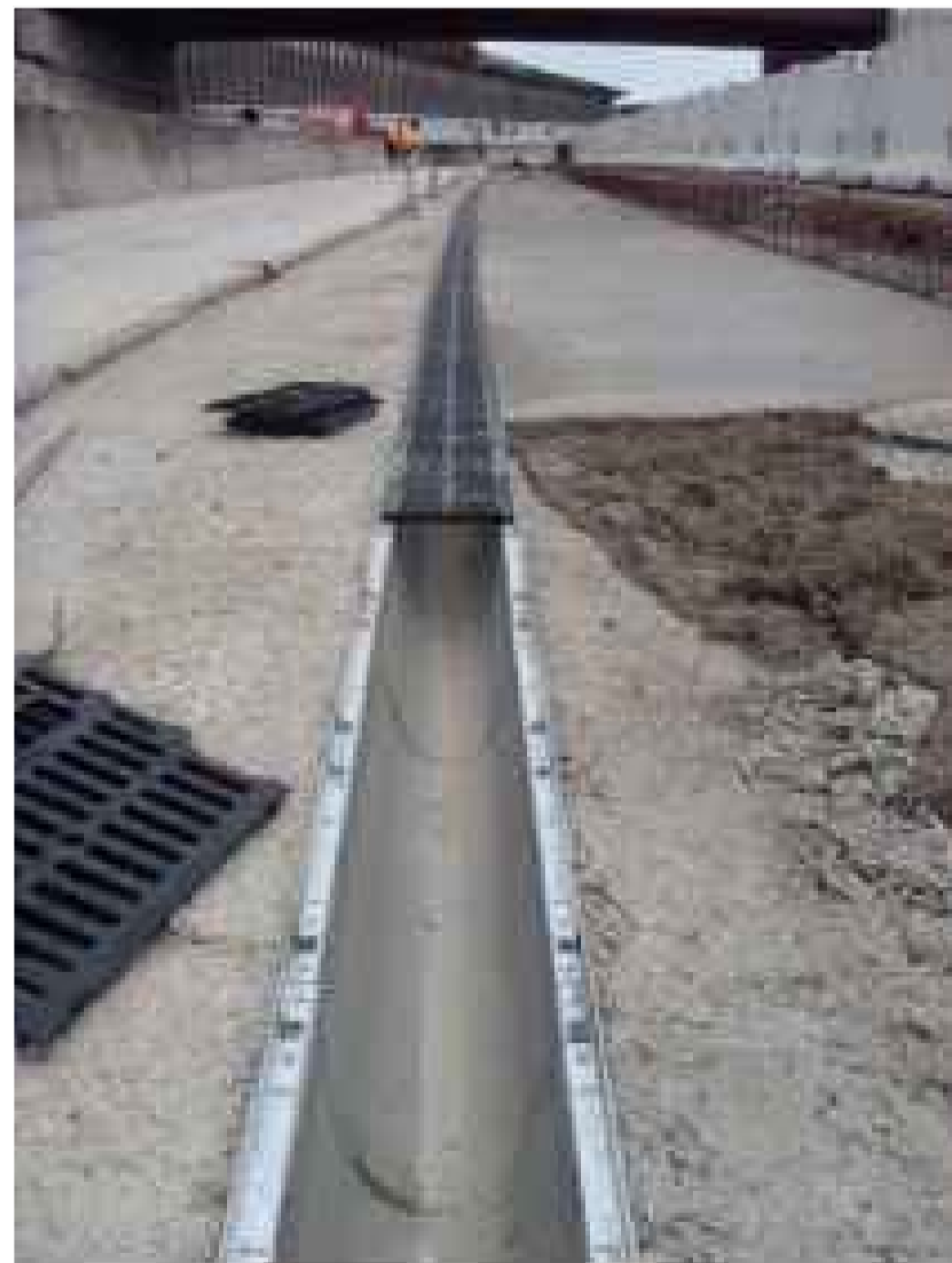
Рис.2 Приклад встановлення водовідних лотків
