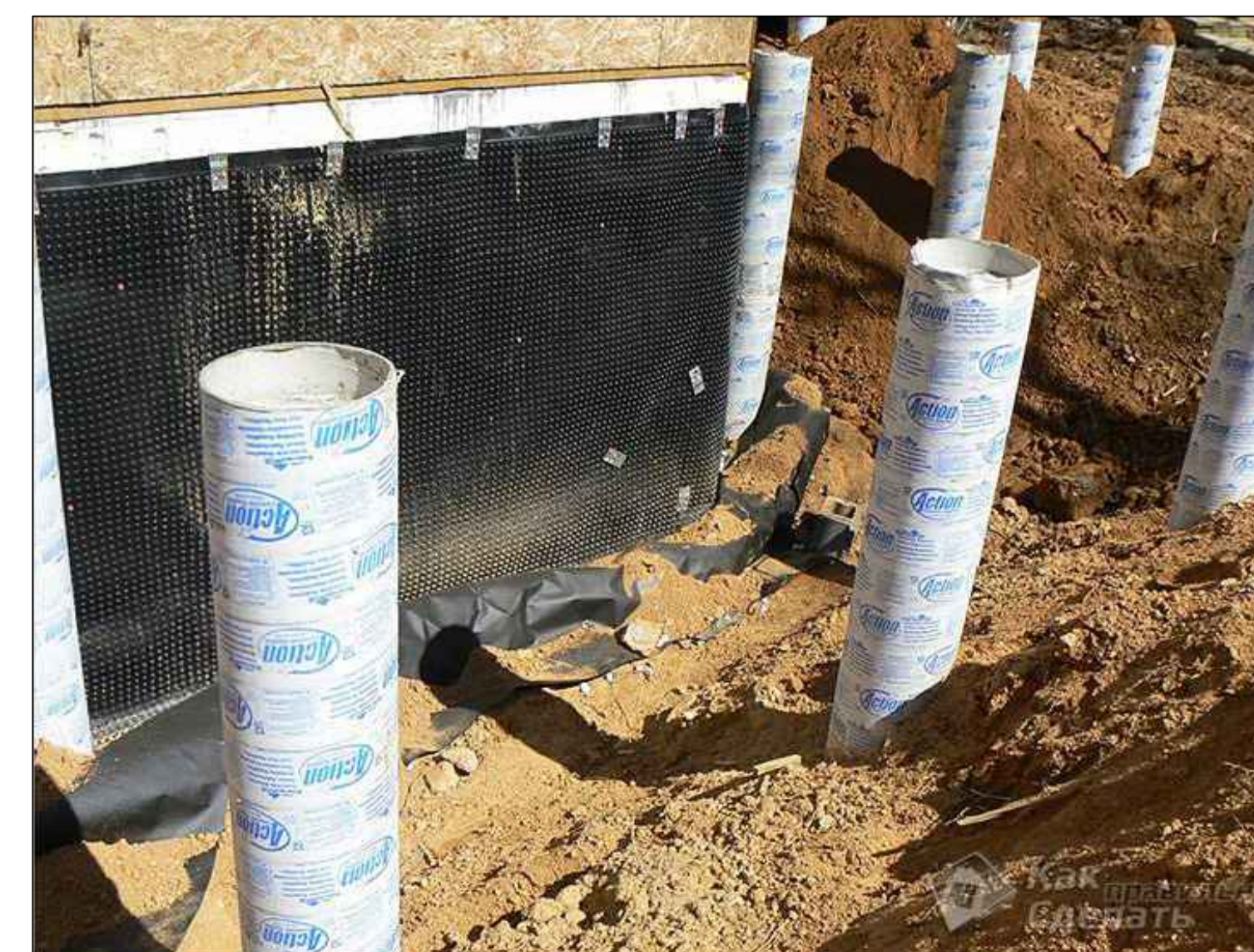
Рис.3 Приклад пристінного дренажу
