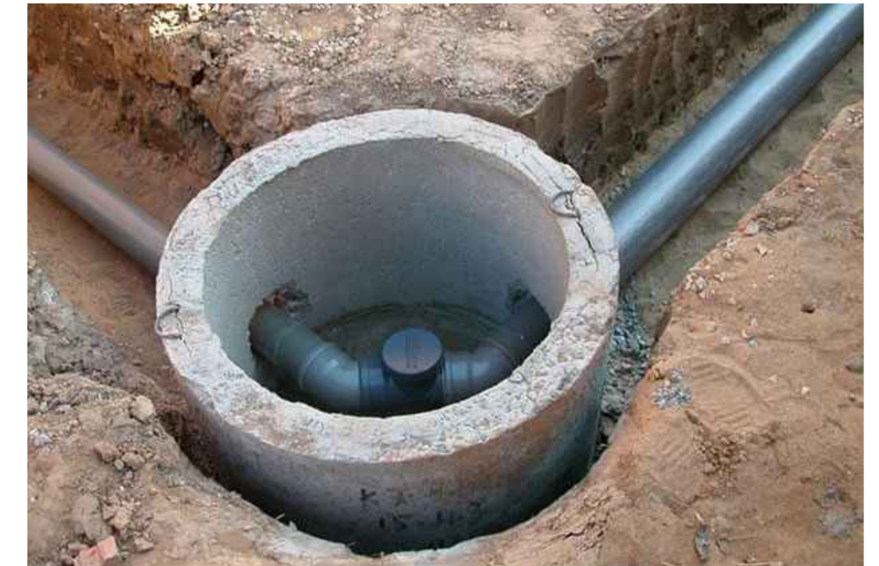
Приклад використання оглядових колодезів
