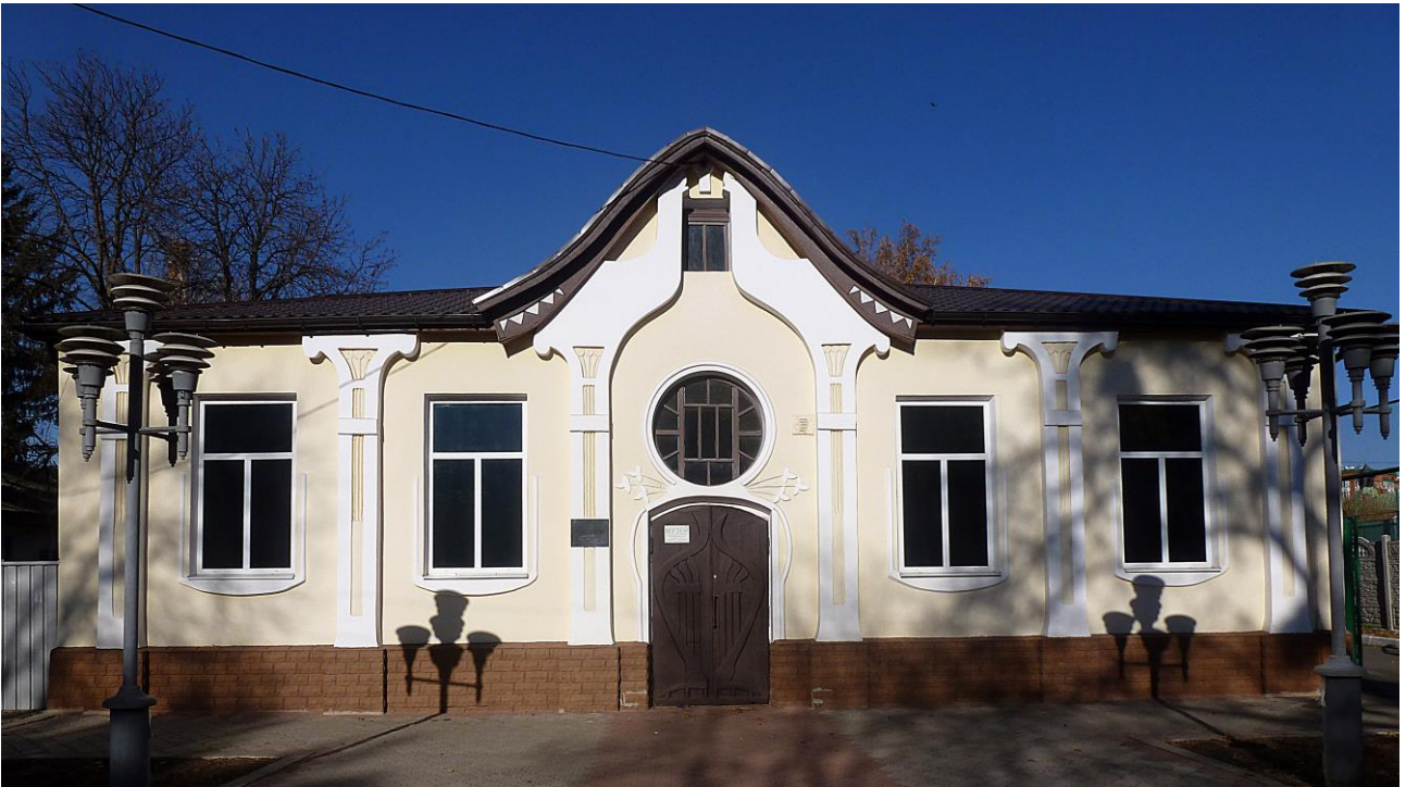
Рис. 1. Будинок по вул. Лідова, 6 (фото М. Белінської 2016 р.)
