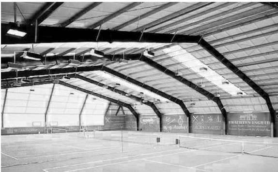
Мал.2 Металеві конструкції
