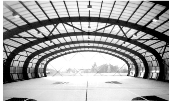
Мал.3 Конструкції з клеєної деревини
