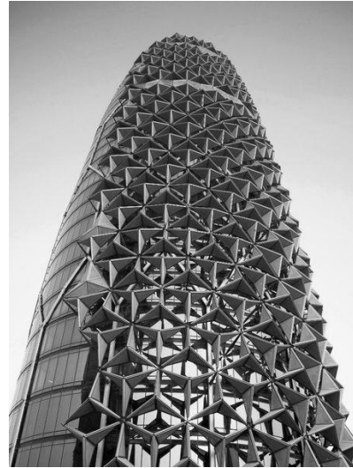
Рис.5. Фрагмент здания Al Bahar Towers в Дубае
