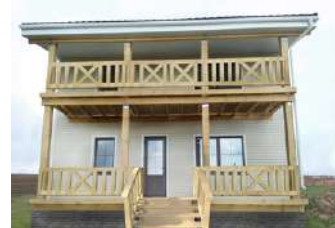
Будинок з соломи в Україні Екобудинок в Очакові (2018 р) Стіни, підлога, перекриття та дах з натуральних матеріалів: дерево, пресована солома, глина, пісок, вапно.
