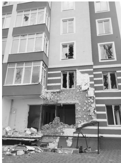
Рисунок. 2 Повне руйнування перестінку.
