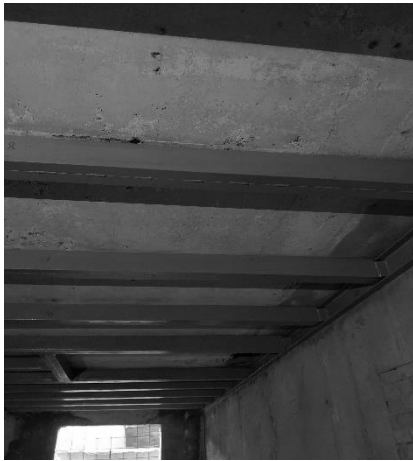
Рисунок. 1 Залізобетонне перекриття, уражене вогнем, після підсилення сталевими балками
