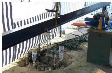
Рис. 3. Общий вид измерительного оборудования на поверхности в процессе испытания сваи
